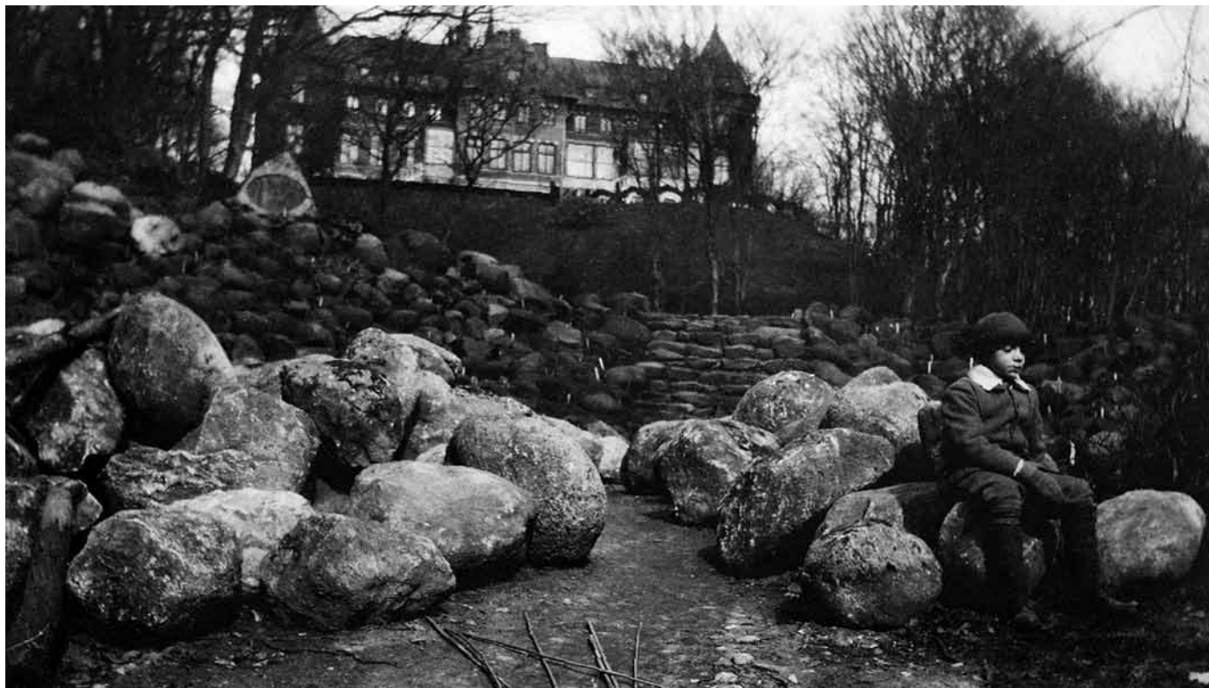
■ Stenpartiet anläggs och prins Gustaf Adolf, som hjälpt mor och far, tar en paus i arbetet. Omkring 1915. (Bernadottebiblioteket, Fotografier, Kr M-a A30e. Fotograf uu, © Kungl. Hovstaterna/Bernadottebiblioteket)
