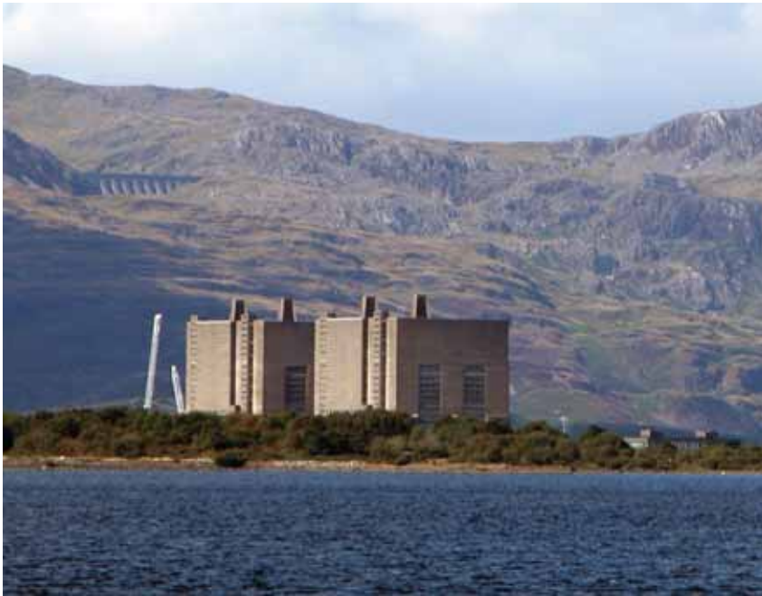
■ Kärnkraftverket Trawsfynydd, omgivningarna ritade av landskapsarkitekten Sylvia Crowe. (Bilden från Wikimedia, foto uu)
