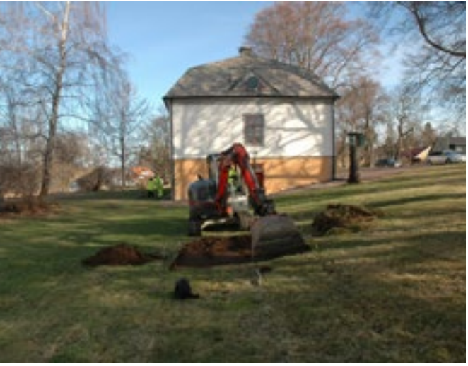
■ Figur 4. Schaktning efter den förmodade orangerilämningen pågår söder om huvudbyggnaden (schakt 5). Foto: Jönköpings läns museum
