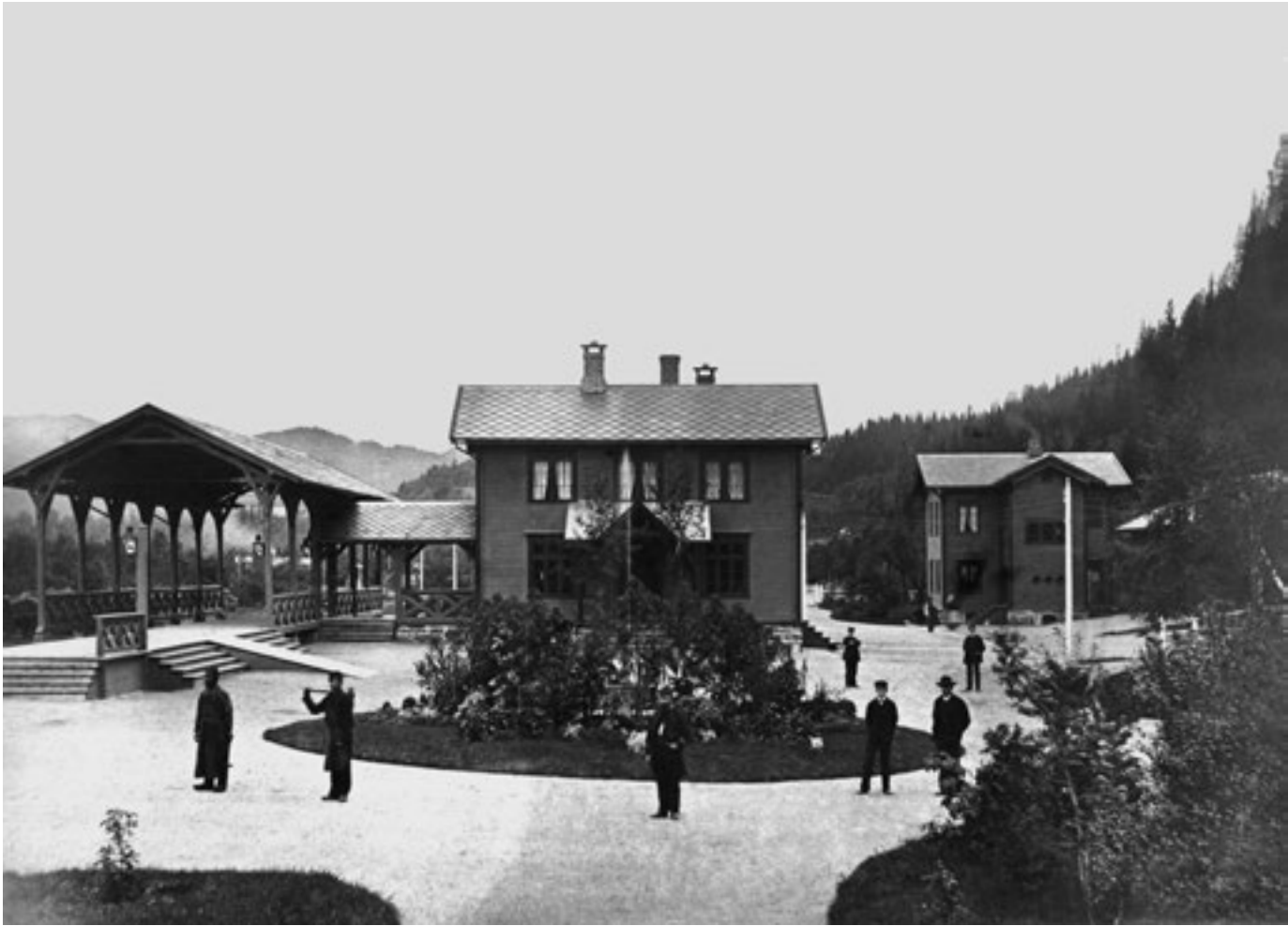
■ Støren stasjon med parkanlegg, foto frå mellom 1880 og 1890. Norsk Jernbanemuseum.
