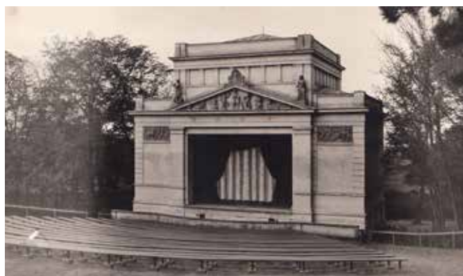
■ Den nya teaterbyggnaden uppfördes år 1919 och är fortfarande i bruk. Foto: Folkrörelsernas arkiv, Helsingborg.
